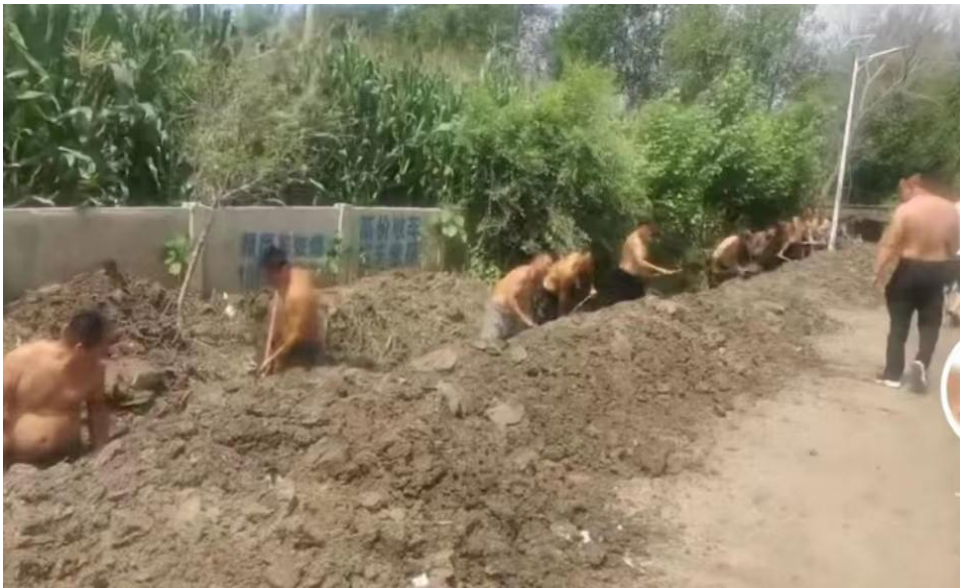
七家子镇榆树村夏季施工现场
